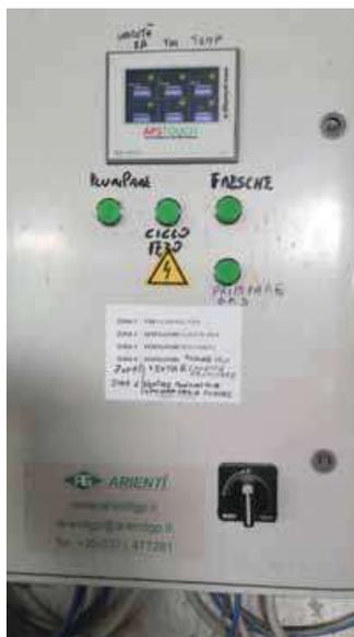
La centralina elettronica che controlla tutto il sistema di raffreddamento della stalla, con suddivisione dei vari settori. Il sistema può funzionare in totale autonomia, ma i fratelli Ancellotti hanno preferito avere un sistema di gestione manuale, con avviamento delle varie fasi. Ad ogni pulsante corrisponde un ciclo di cooling e una determinata area della stalla.
